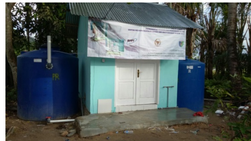
Gambar 10. Tangki Penampung & Bangunan Pelindung
